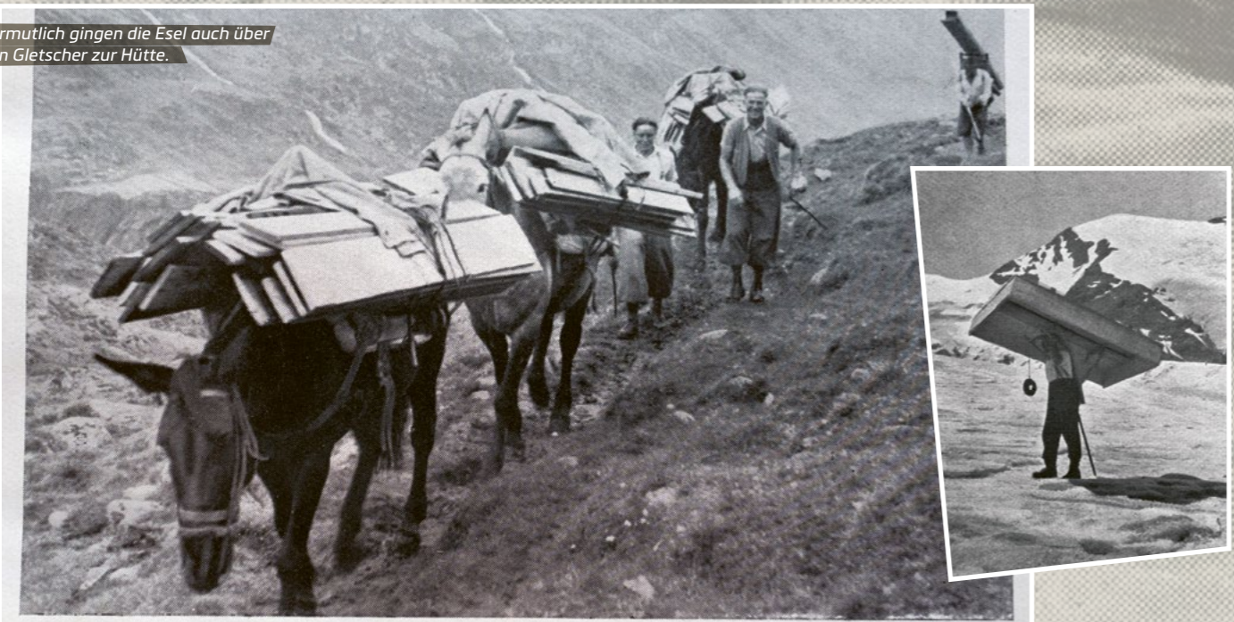
Transport-Schwierigkeiten. Für den Neubau mussten 120.000 kg mittels Geländewagen, Muli und Drahtseilbahn auf 2883 m hinaufgeschafft werden. Bild 1: Ein Kasten wird über den Gletscher getragen. — Bild 2: Im Schnee eingetretener Muli. — Bild 3: Baumaterialienkarawane unterwegs. (Bild 1 und 2 Aufn.: Pohl, Bild 3 Aufn.: Straffer)
